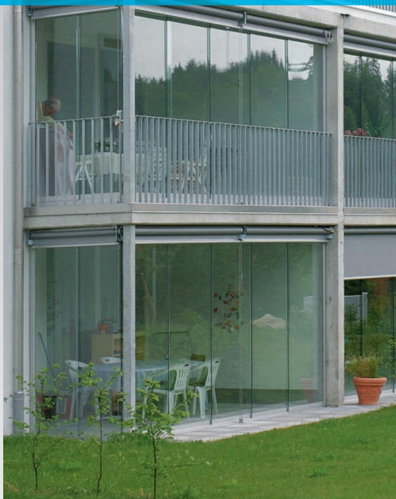
Das verwendete Glas ist ESG-Sicherheitsglas, wobei die sichtbaren Glas-kanten geschliffen, poliert und facettiert sind.
